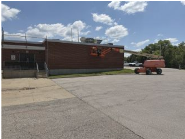
2026.07.30 – Caulking exterior CJ
